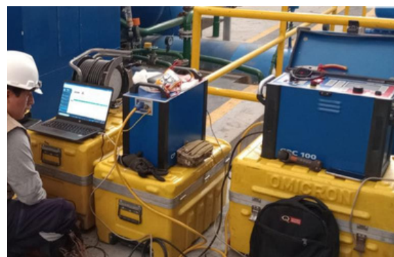
EQUIPO DE DESCARGAS PARCIALES
